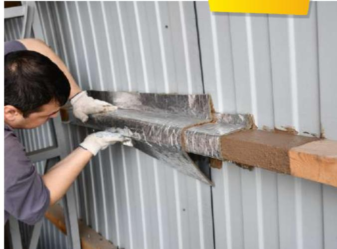
Максимальная дополнительная нагрузка, создаваемая смонтированной системой «ЕТ ДРЕВО» при двухслойном монтаже «МБОР-Ф» толщиной 10 мм, не более 5,6 кг/м<sup>2</sup>.
