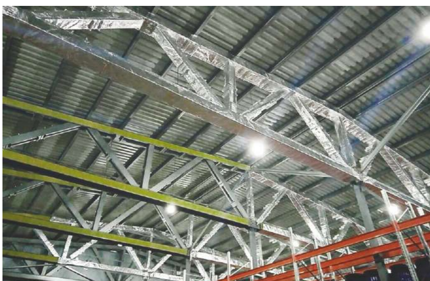
Защита легких стальных тонкостенных конструкций
