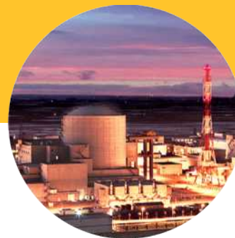
Tianwan NPP, China
