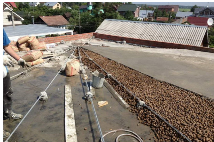
Создание уклонов традиционным способом с использованием керамзита и легких бетонных смесей.
