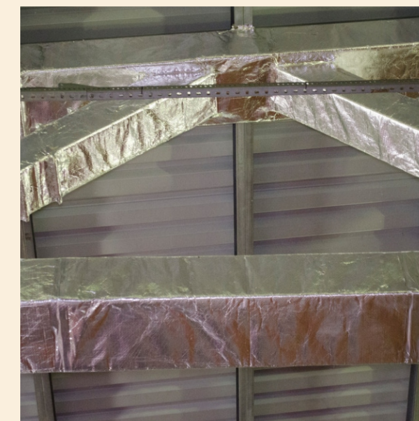
Так выглядят конструкции, защищенные ЕТ ЛСТК
