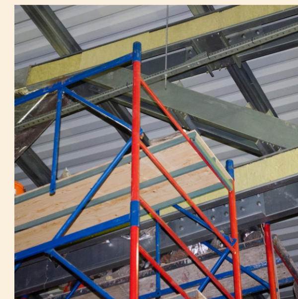
Процесс монтажа огнезащиты ЛСТК
