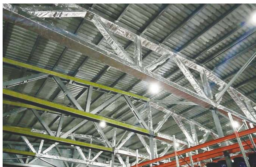
Защита легких стальных тонкостенных конструкций
